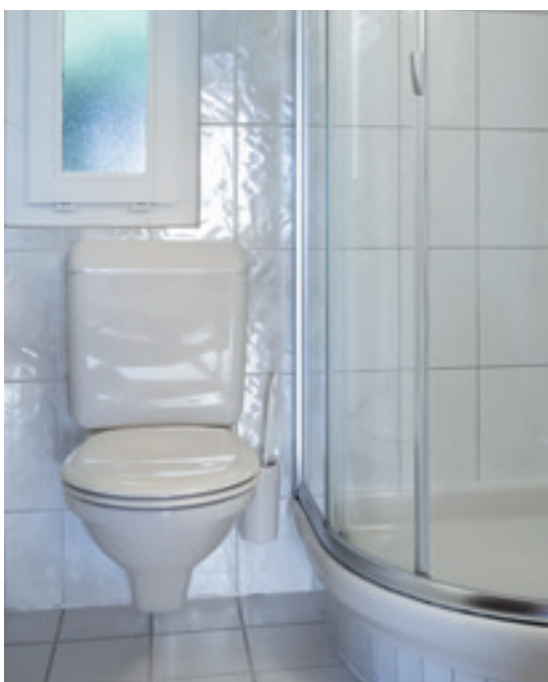
VORHER Einbausituation mit Aufputzspülkasten
